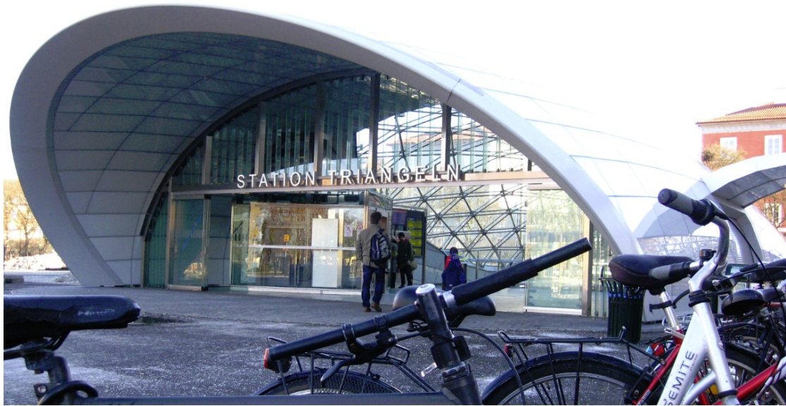
Photos 5 et 6. La nouvelle station hi-tech de Triangeln.
